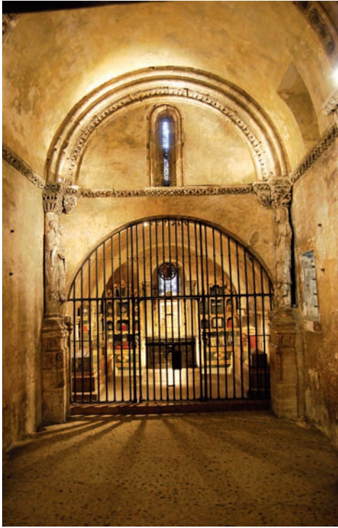
Fig. 4. Cámara Santa. Vista de la capilla de San Miguel hacia el Este. Foto: CGCV
