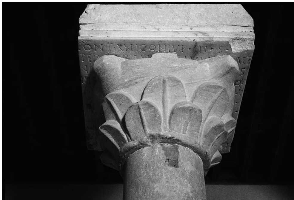
Epitafio romano reaprovechado como cimacio (San Miguel de Escalada, prov. de León): los dhimmies que emigraron o huyeron a territorio cristiano a lo largo de los siglos IX y X trasladaron consigo una técnica constructiva basada principalmente en la reutilización de materiales.
