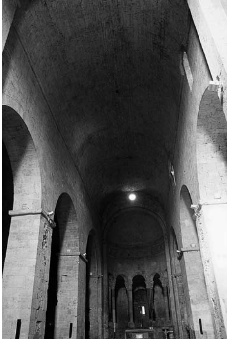
Figura 6. Besalú. Sant Pere. Nave mayor.
