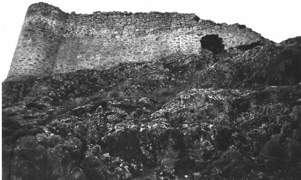
Espolón meridional, con los merlones cegados por un posterior recrecimiento del muro
