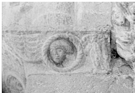
Fig. 2 Imposta. Iglesia, muro sur.
