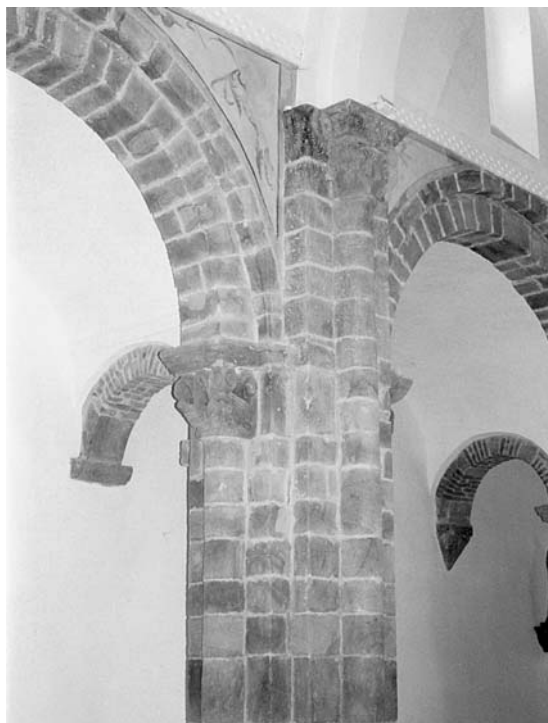
Fig. 4. Pilar del segundo tramo de las naves (segunda fase constructiva del templo).
