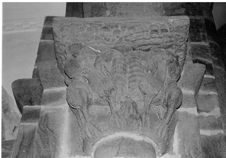
Fig. 7. Detalle de capitel (segunda fase constructiva del templo).
