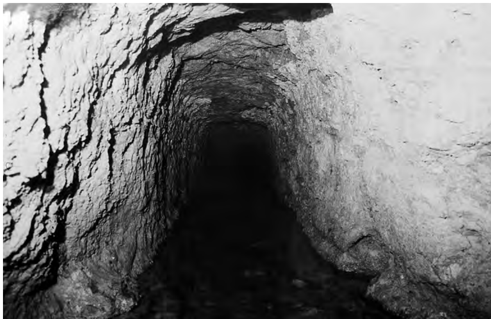
Fig. 13: Aspecto parcial de la galería subterránea explorada .
