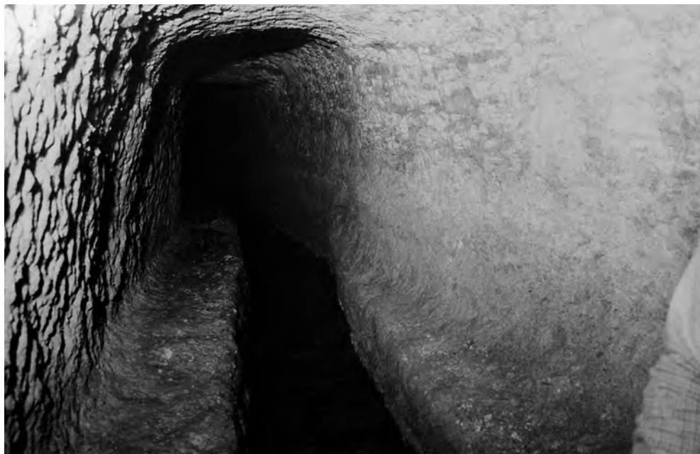
Fig. 12: Aspecto parcial de la galería subterránea explorada.
