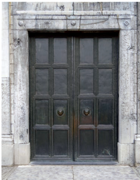
Fig. 9. Portal principal, Wolfstür (puerta del lobo), Aquisgrán, Münster (catedral)
