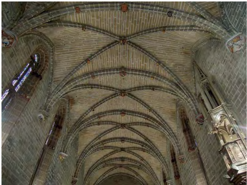
Fig. 2. Bóveda del refectorio de la catedral de Pamplona (Foto: autor)
