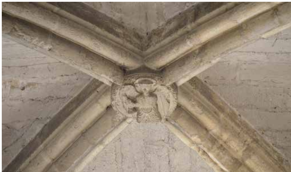
Fig. 10. Ángel ceroferario Fig.do en la clave de bóveda del presbiterio de la iglesia del monasterio de Vallbona de les Monges (foto: autora)
