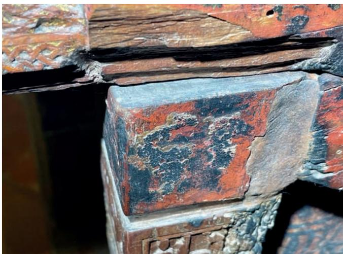
Fig. 7. Inclinación del león, debido a un desajuste por haber sido el travesaño vertical cortado ligeramente por encima del travesaño horizontal (Foto: V. Roonthiva)
