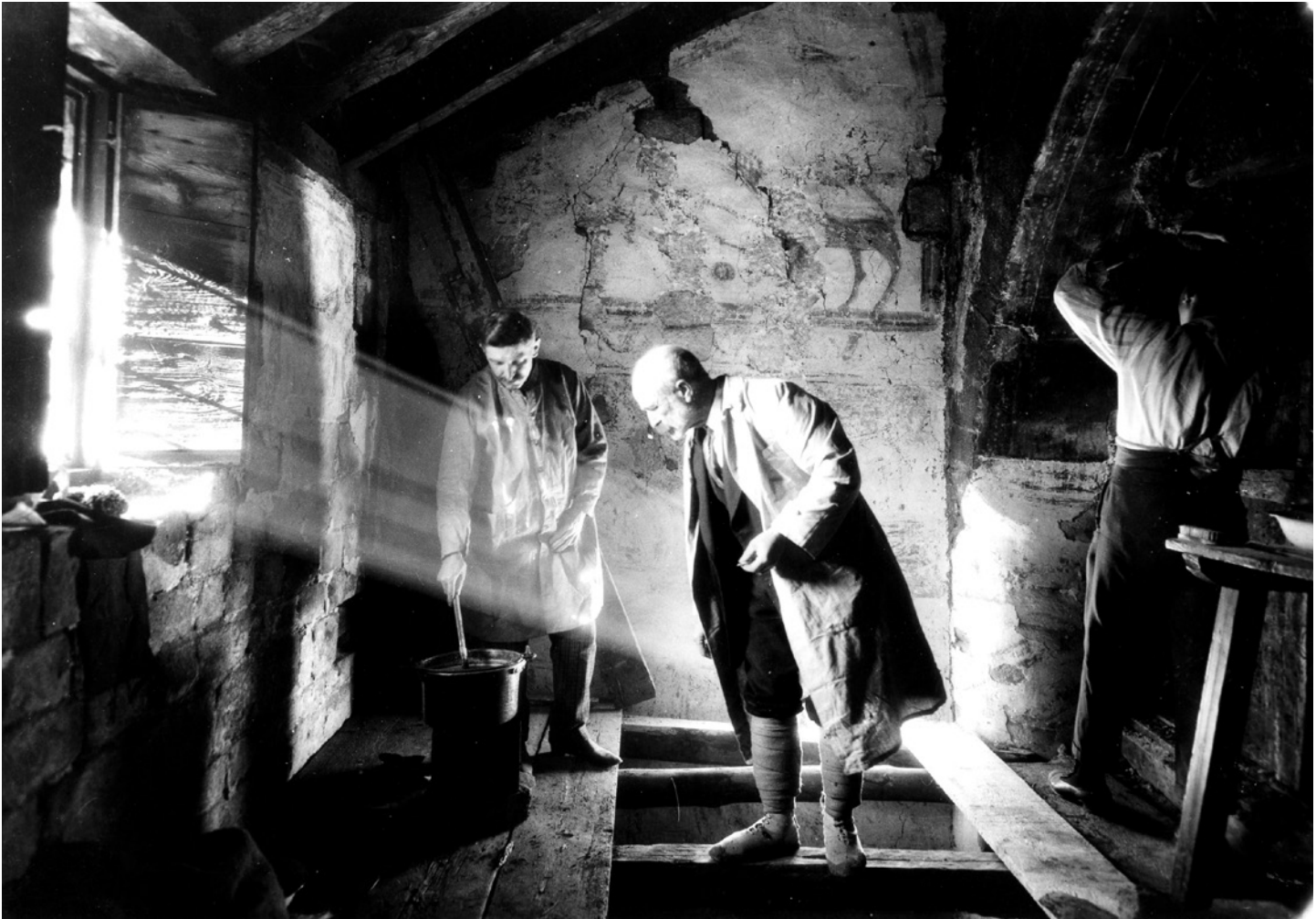
Santa Maria de Taüll, 1922: trabajos para el arranque de las pinturas murales. Foto: Arxiu Amatller d'Art Hispànic
