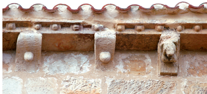
Otros canecillos del muro sur
