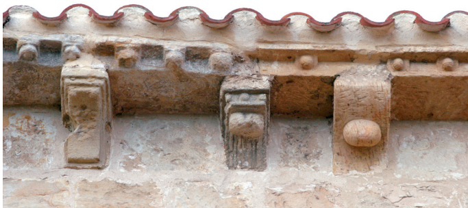
Canecillos 4, 5 y 6 del muro sur
