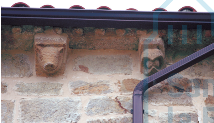
Muro norte. Cornisa y canecillos
