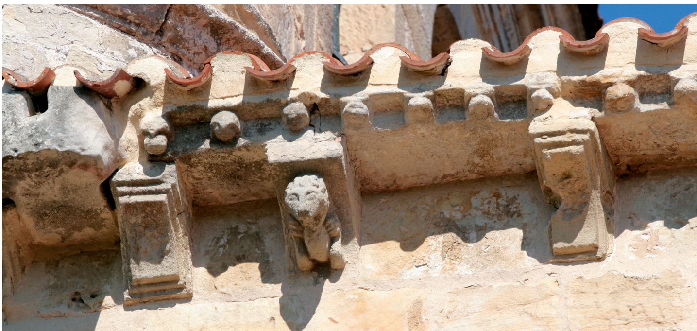
Canecillos 2, 3 y 4 del muro sur
