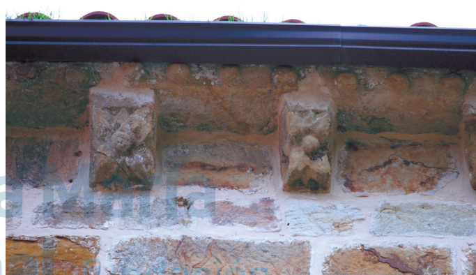
Muro norte. Canecillos con rosáceas
