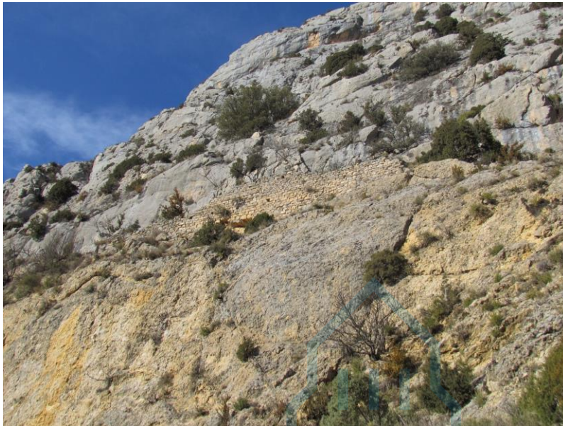
Vista exterior del muro sur
