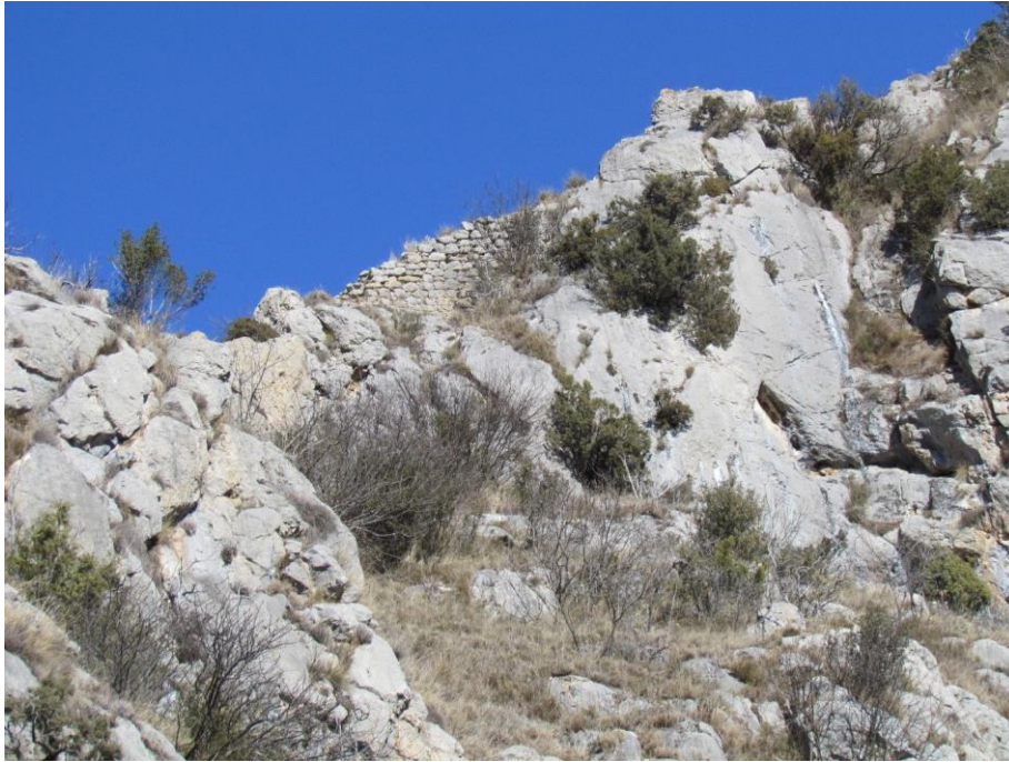
Restos del muro
