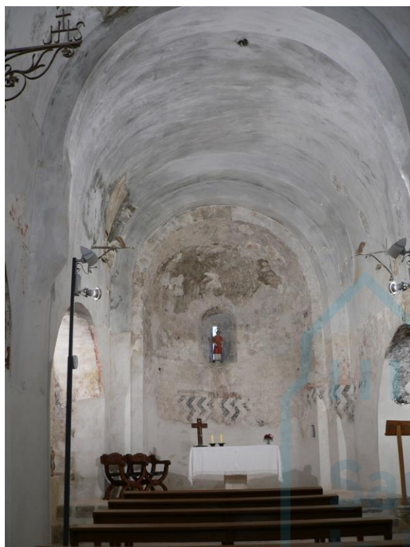
Interior del ábside central
