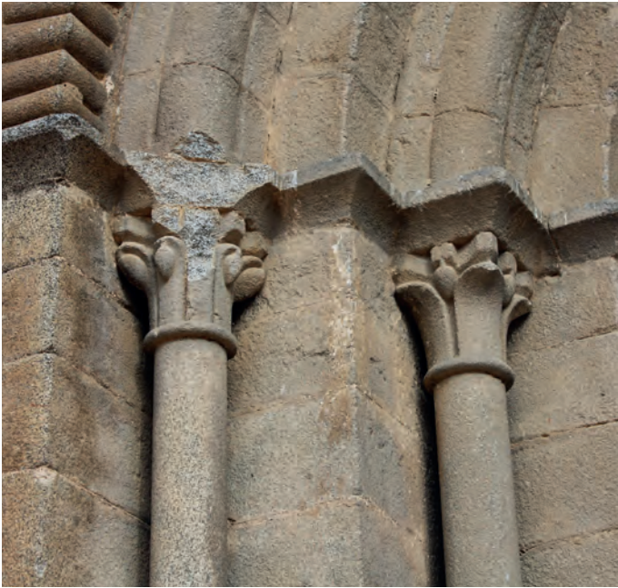
Detalle de la portada (lado oeste)
