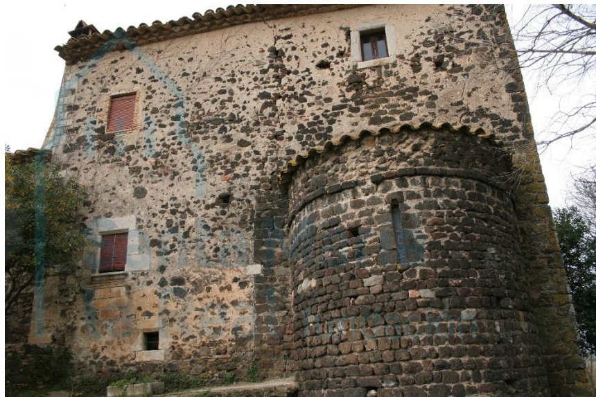
Ábside de la capilla
