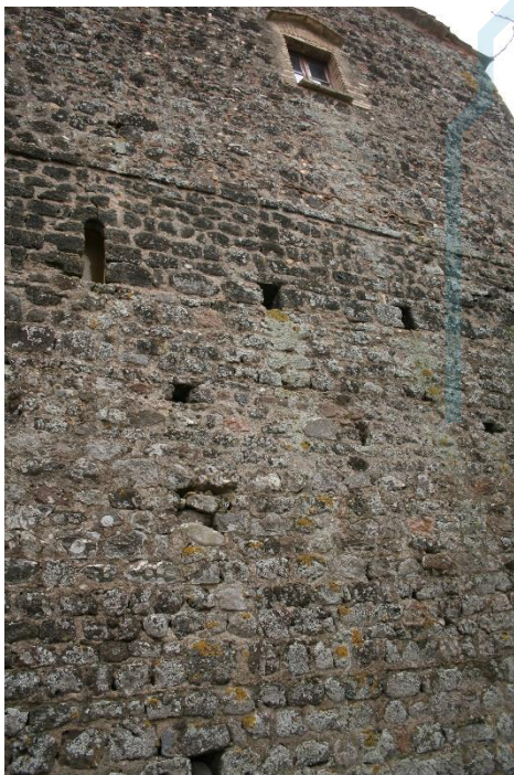
Detalle del muro lateral
