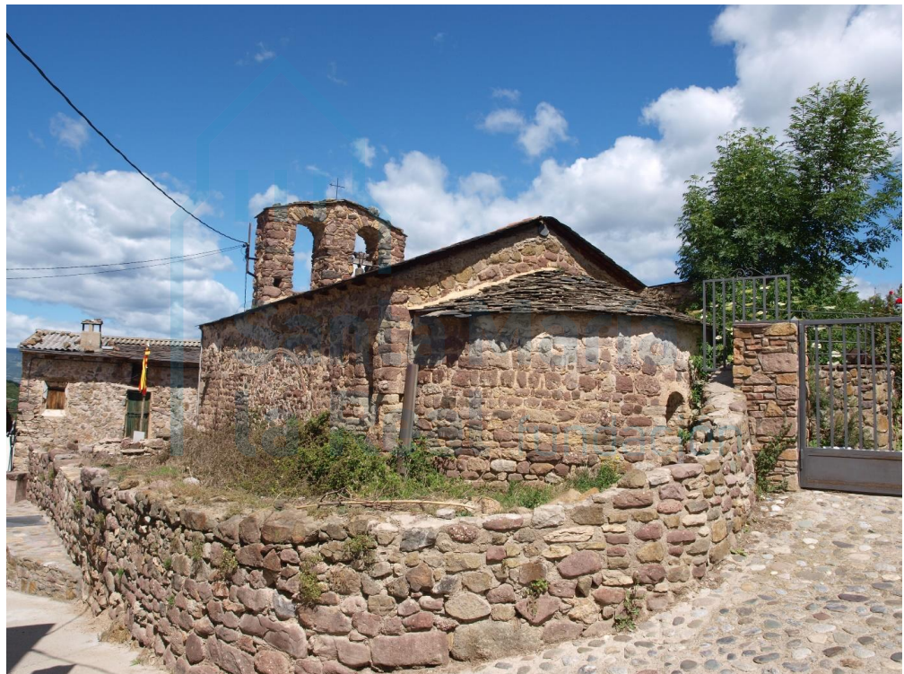
Vista general desde el sureste
