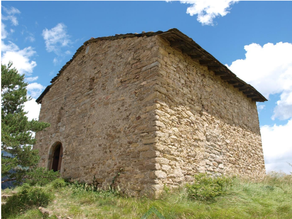
Vista general desde el suroeste
