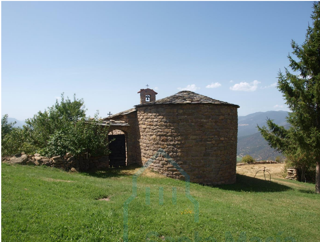
Vista general desde el sureste
