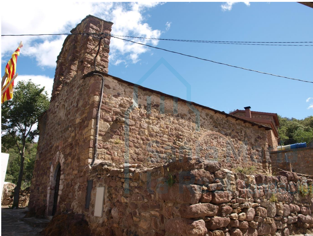
Vista general desde el suroeste
