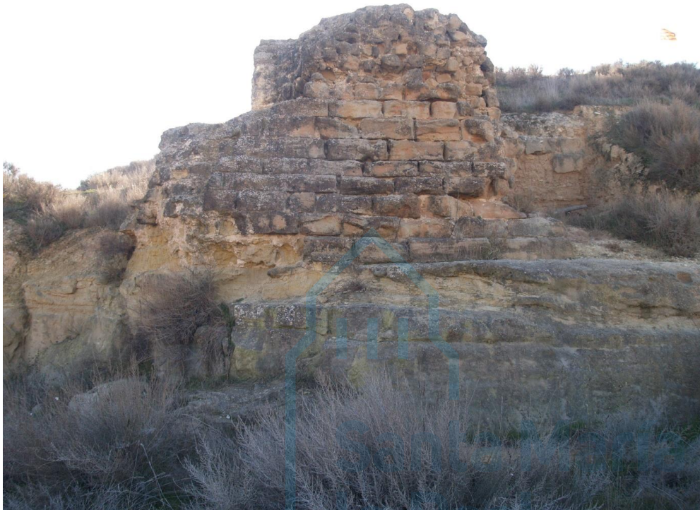
Restos de la muralla
