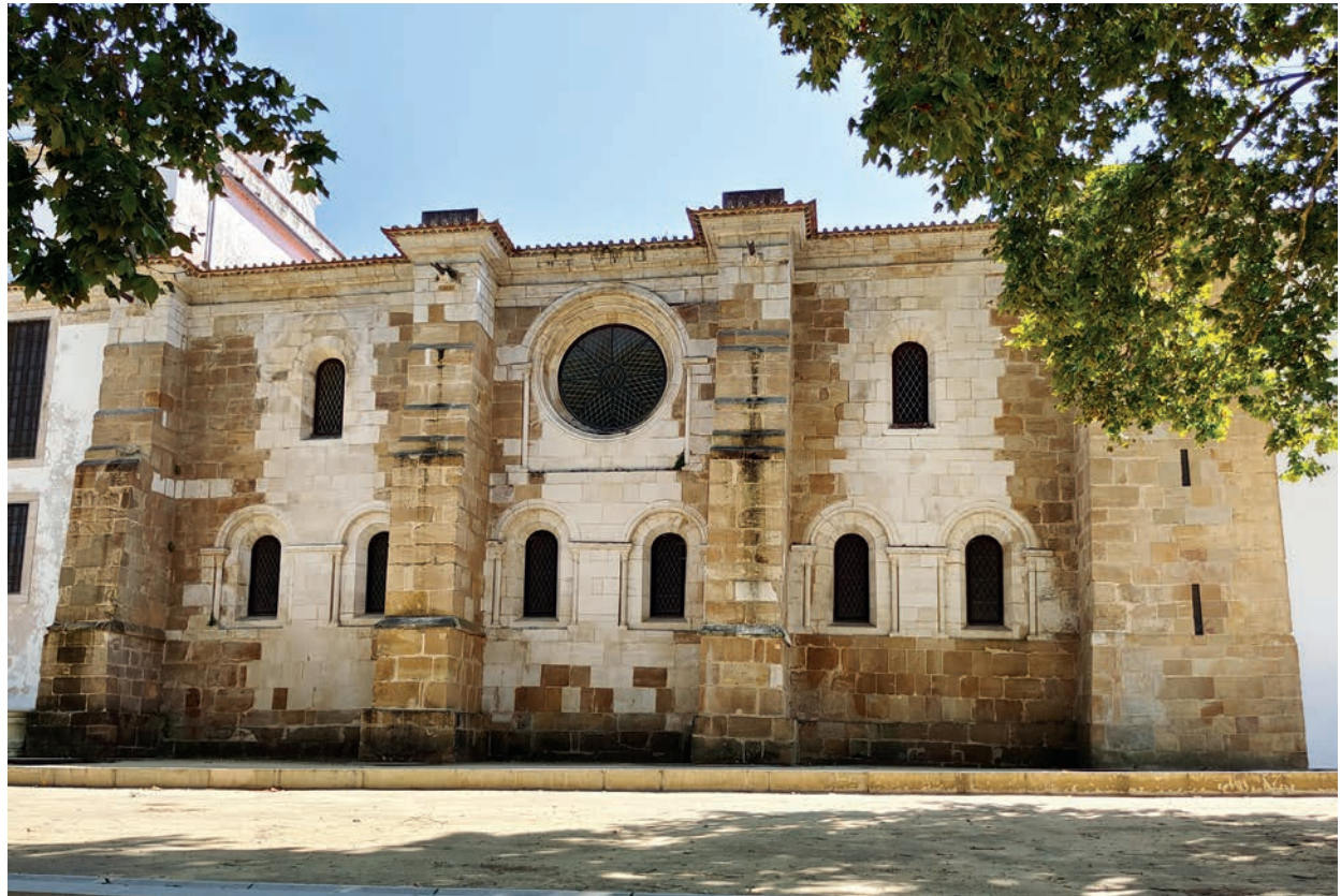
Fachada norte do conjunto monástico
