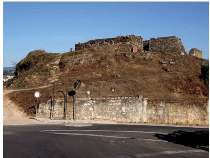
Acesso atual, pelo lado oeste
