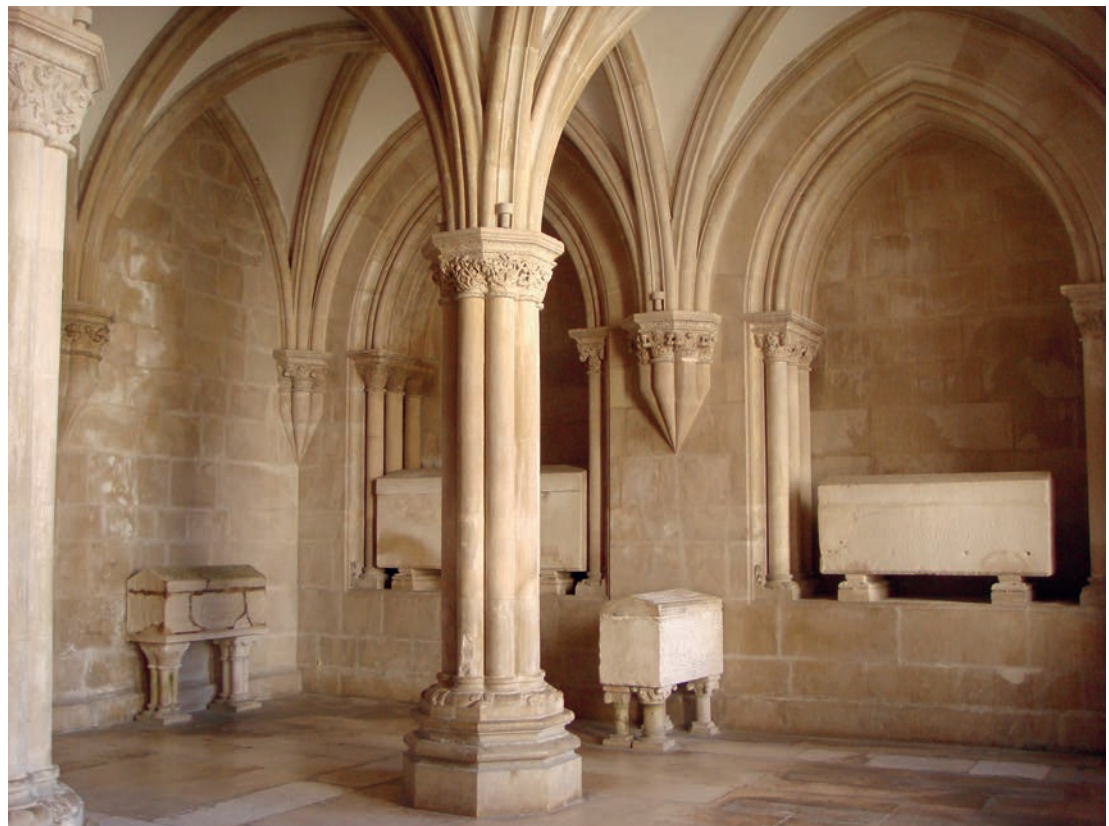
Aspeto geral da Sala dos Túmulos, panteão neogótico erguido nos finais do séc. XVIII
