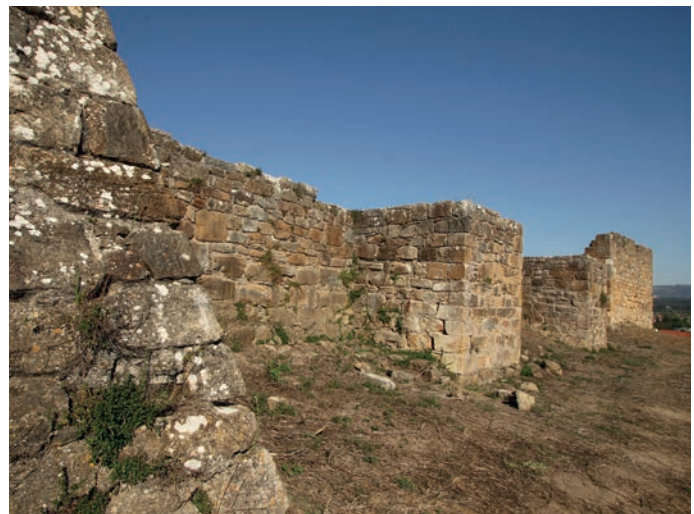
Pano de muralha voltado a sul
