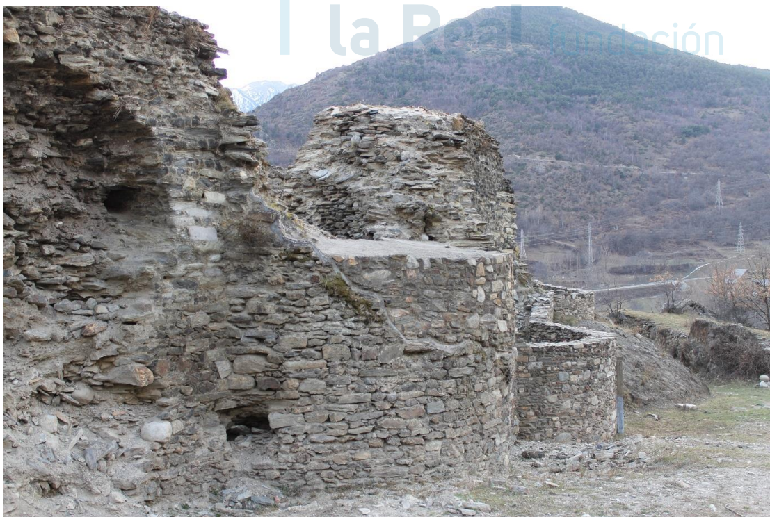
Detalle de la muralla
