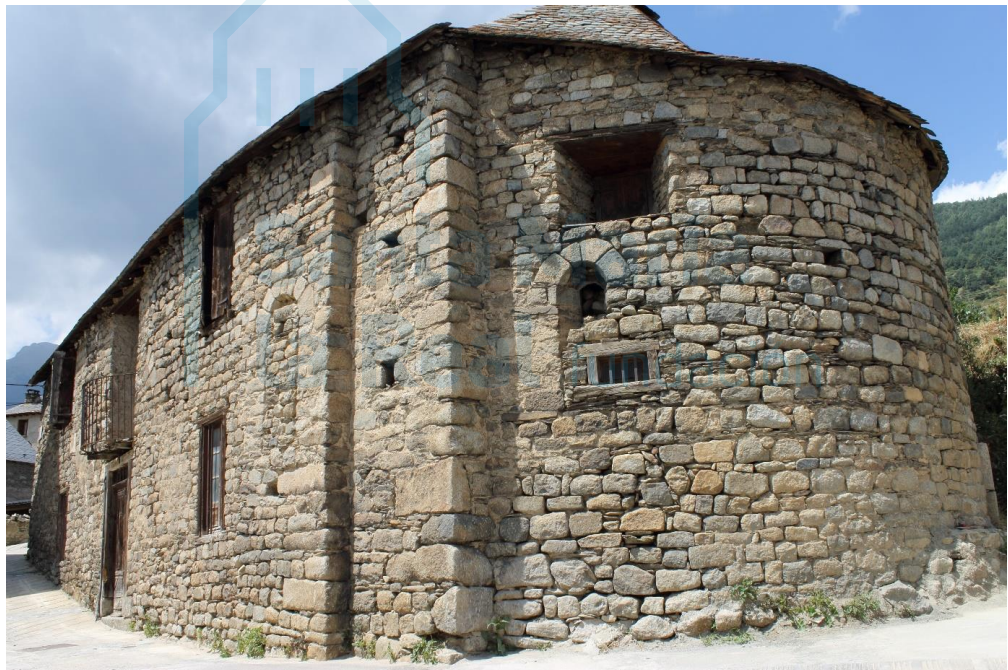
Ábside y muro sur
