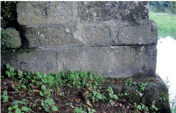
Estribo do pegão na margem direita: alguns silhares siglados
