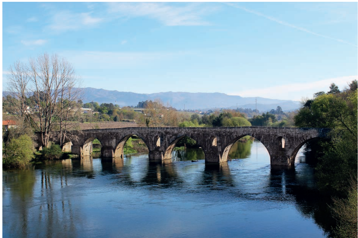
Perspetiva geral da ponte a jusante
