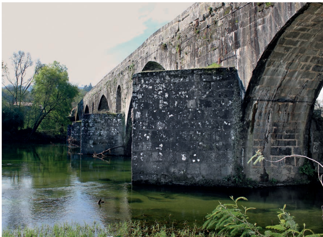
Pespetiva da ponte amontante. Talhamares
