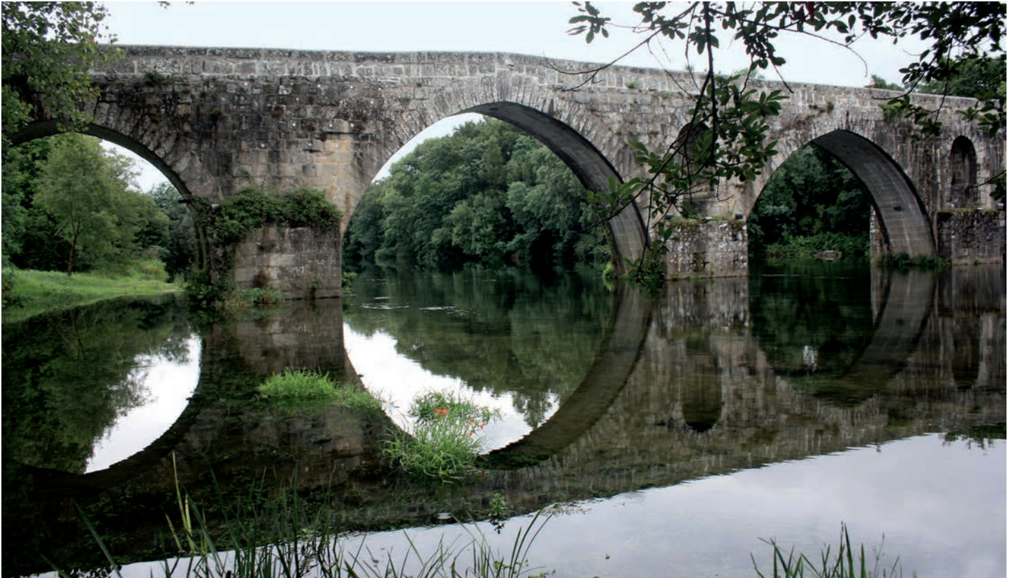
Perspetiva da ponte a jusante
