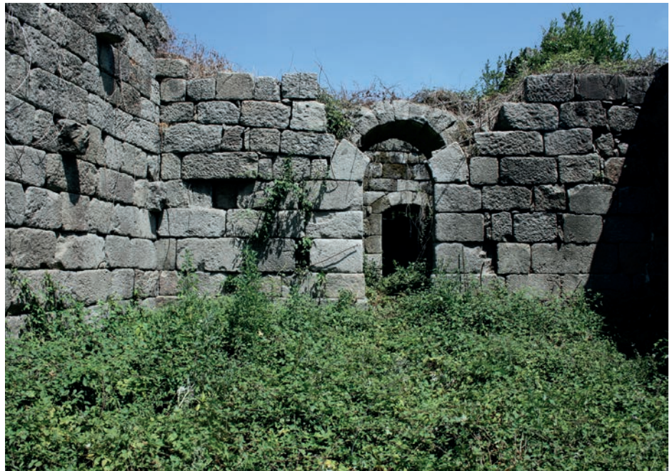
Vista do espaço interior do anexo residencial e porta de acesso à zona da torre
