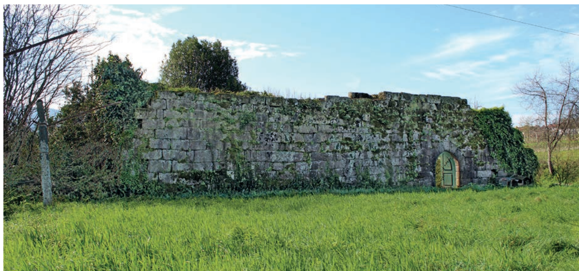
Vista geral da fachada principal da torre e anexo residencial
