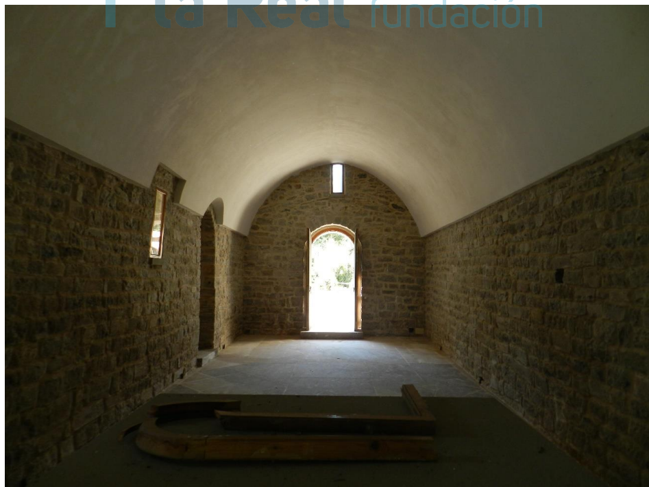
Vista interior hacia el oeste
