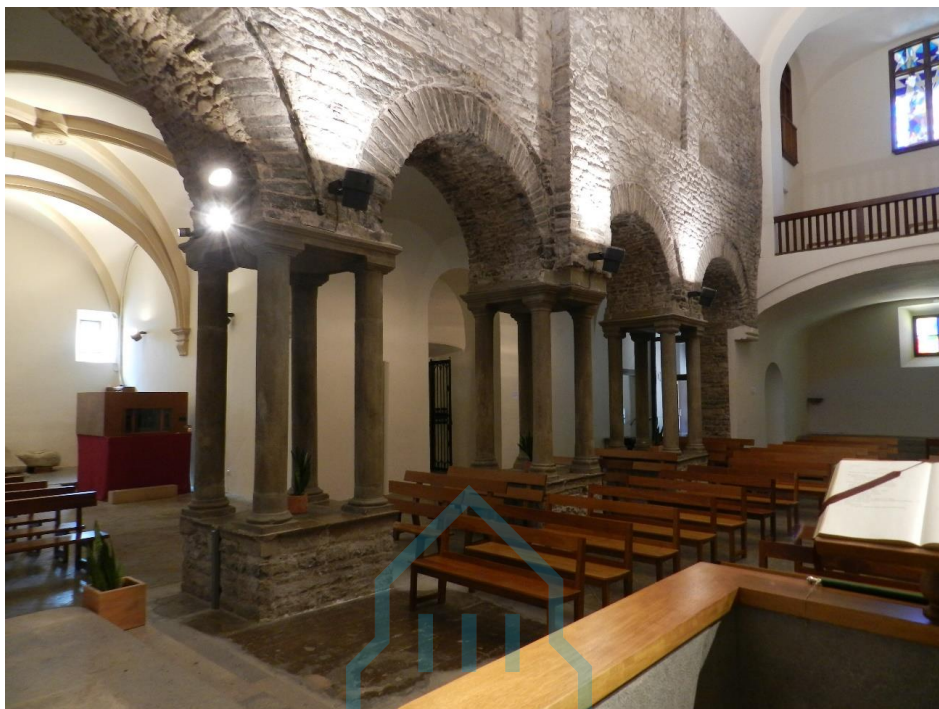
Vista desde la nave central
