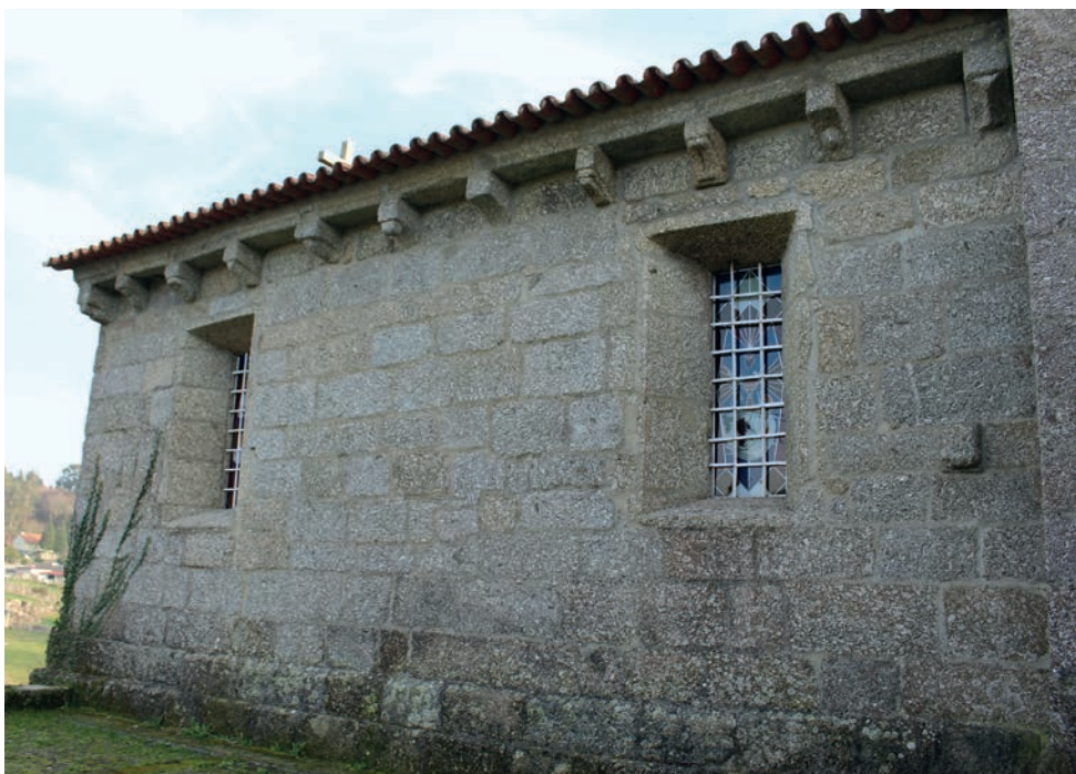
Exterior. Capela-mor. Lado norte
