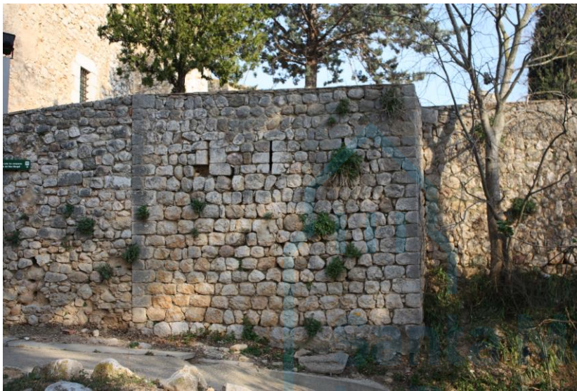
Restos de la torre
