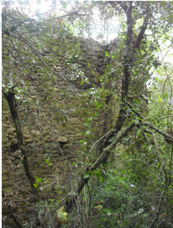
Restos de muro
