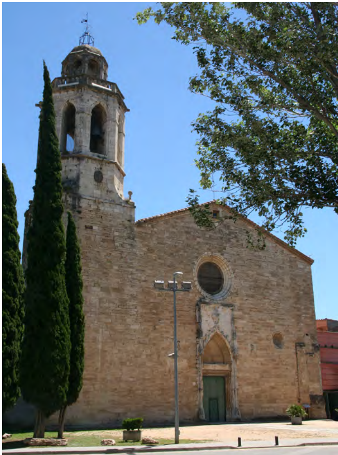
Vista del conjunto actual
