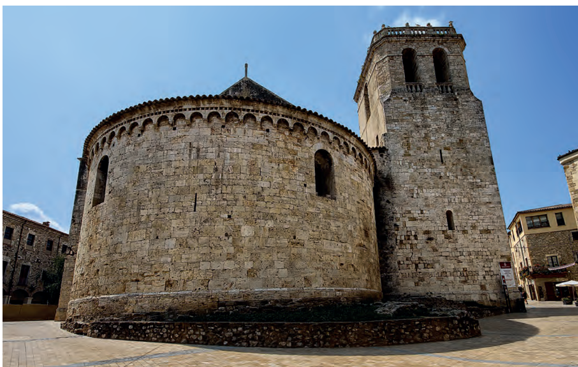
Cabecera y torre
