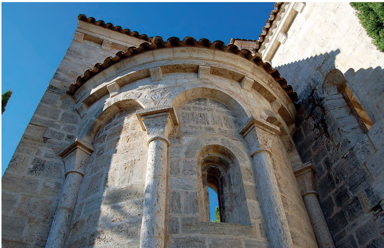
Estado actual del exterior de la cabecera
