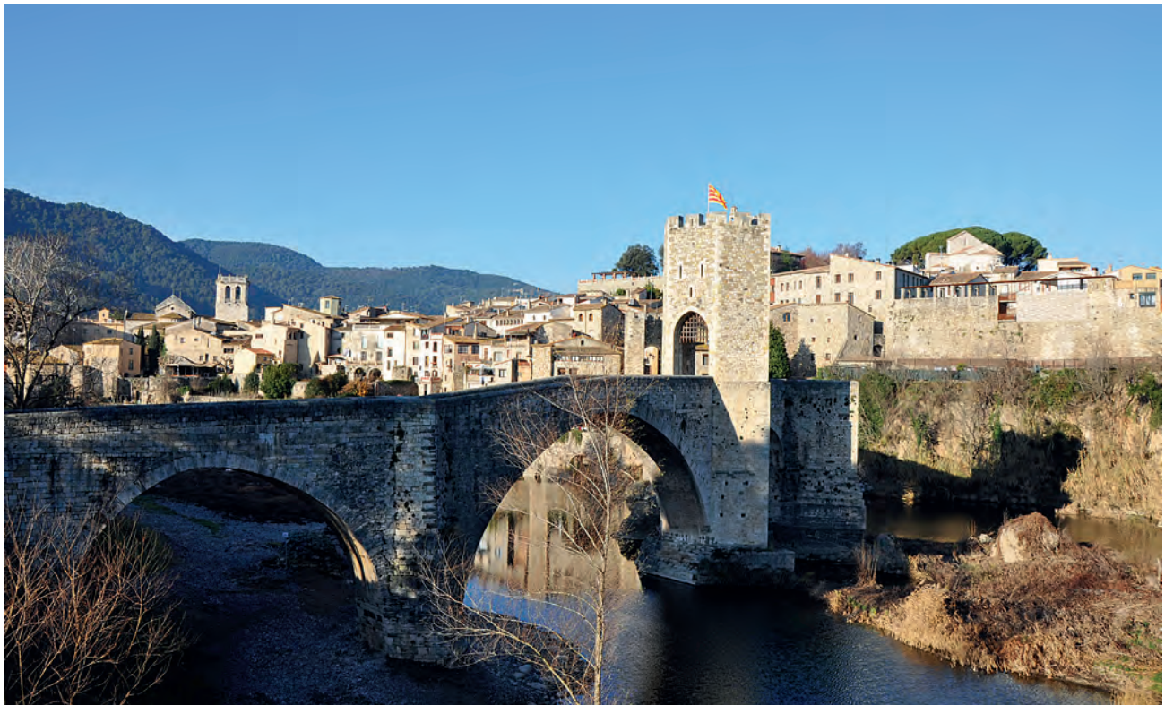
Vista general del puente y la villa
