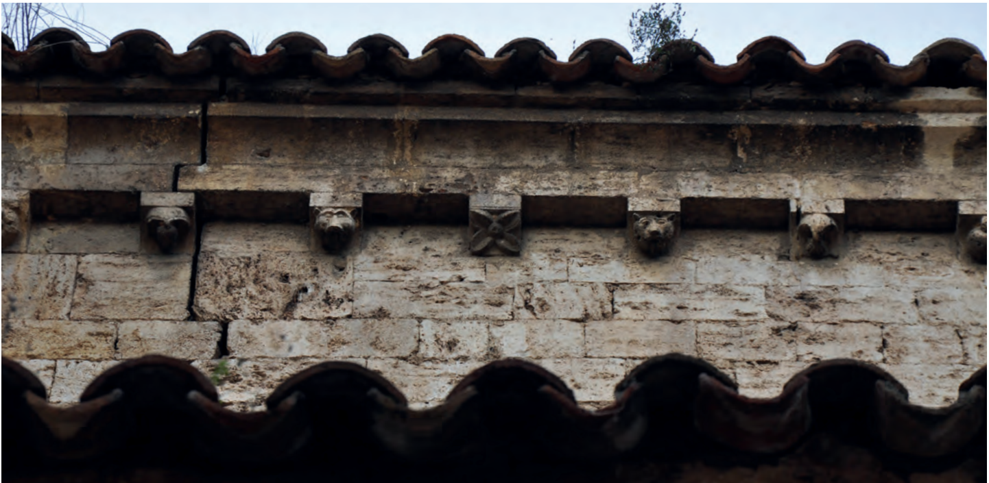
Ménsulas del exterior de la nave
