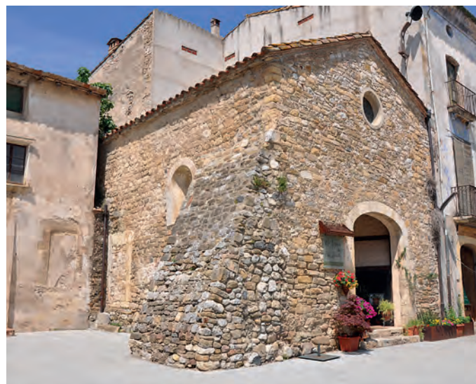
Vista general de la capilla
