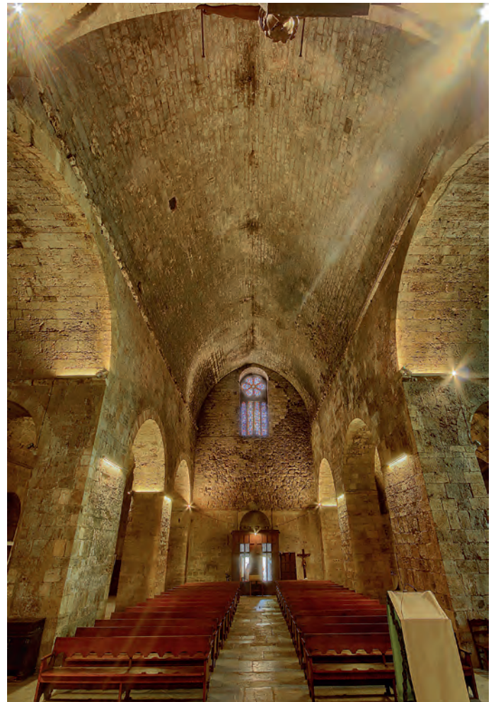
Interior: nave central hacia el Oeste
