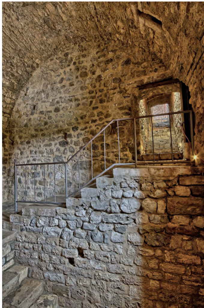
Escaleras de acceso a la mikveh
