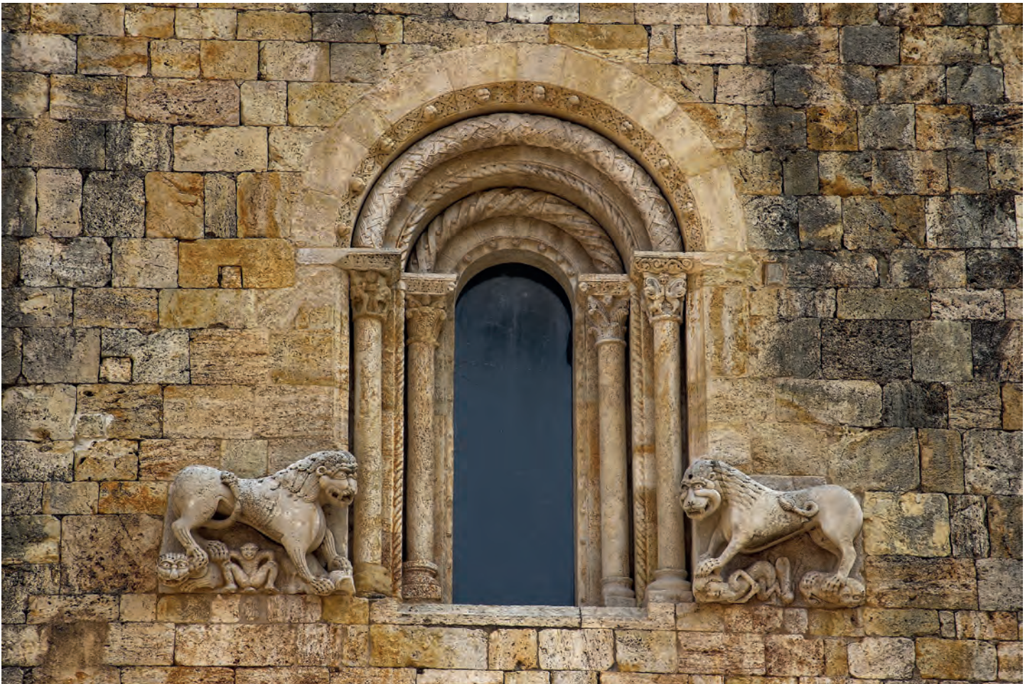
Ventana de la fachada occidental
