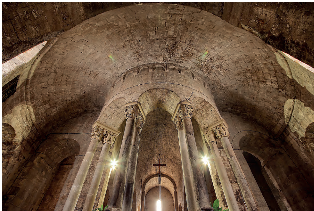
Deambulatorio hacia el Oeste
