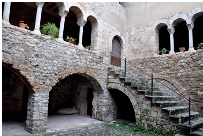
Escalera de acceso al piso superior
