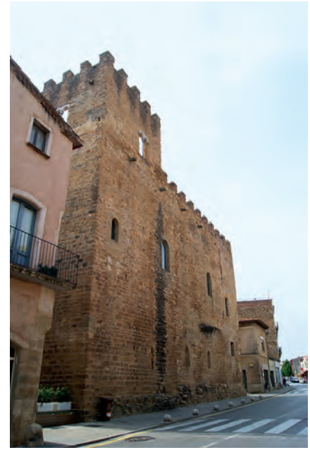
Fachada trasera (oeste)
