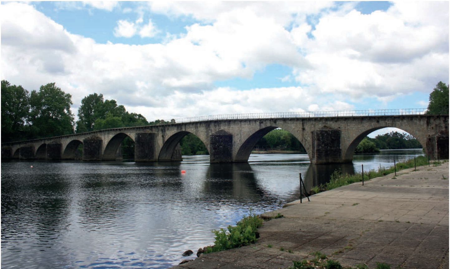
Perspetiva da ponte a montante
