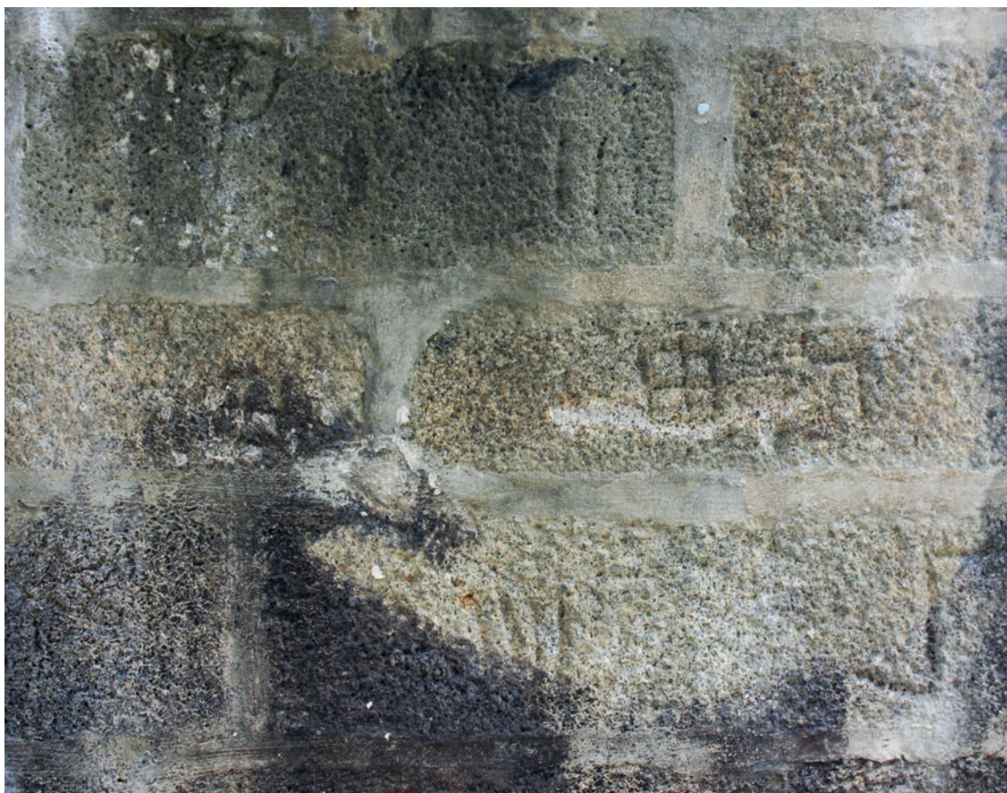
Silhares siglados no intradorso do primeiro arco da margem direita
