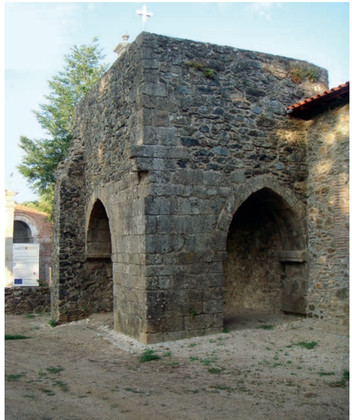
Torre no adro da igreja
