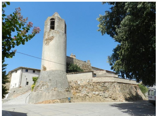
Vista de la torre Suroeste
