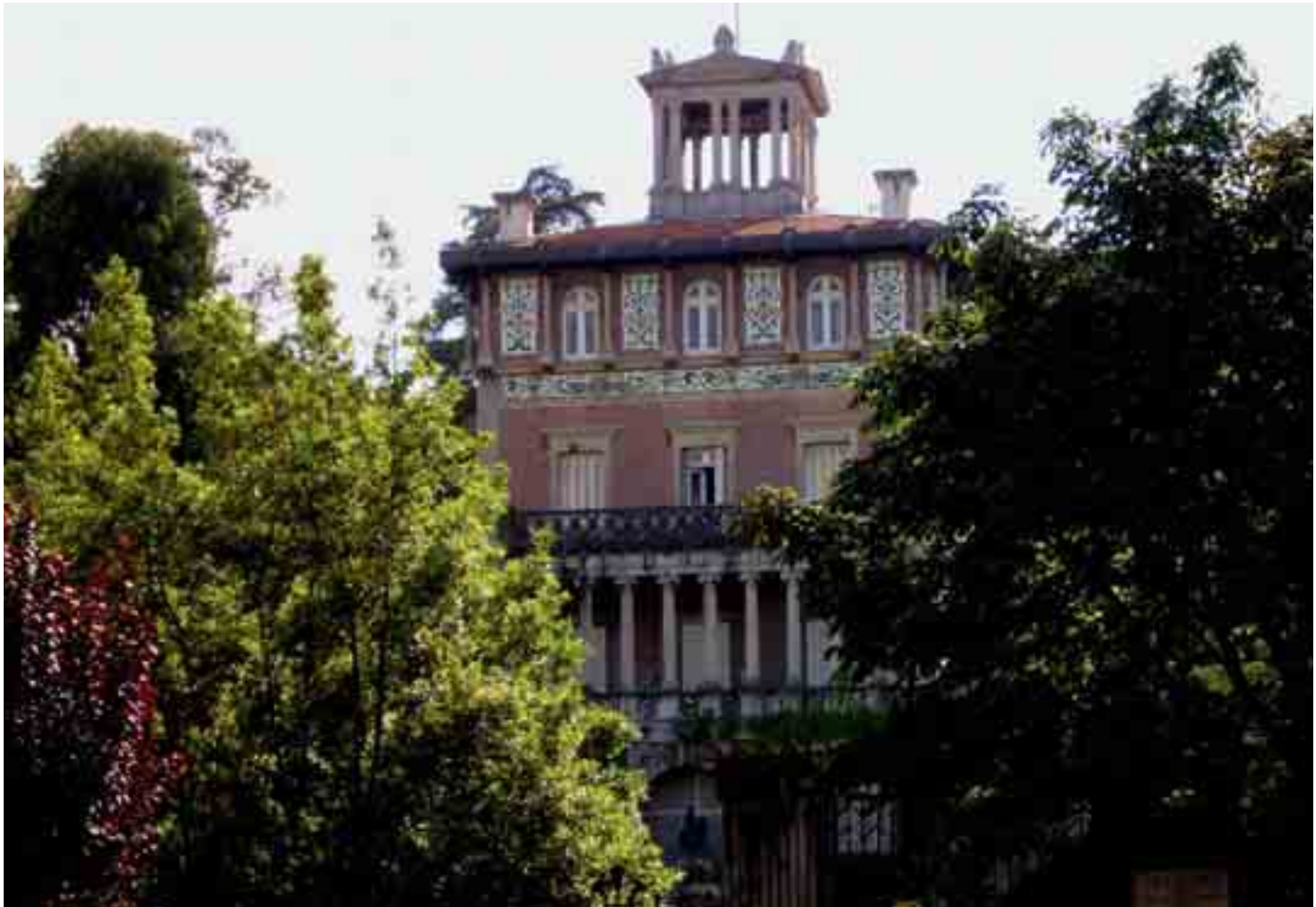
Edificio Toki Eder, construido por Eladio Laredo, declarado Bien de Interés Cultural con la categoría de Monumento
