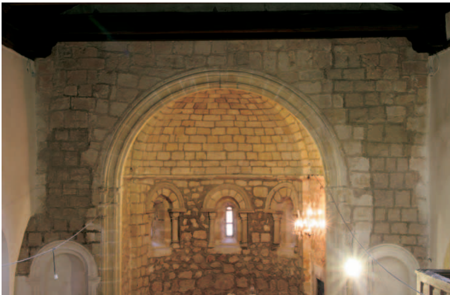
Interior del ábside
