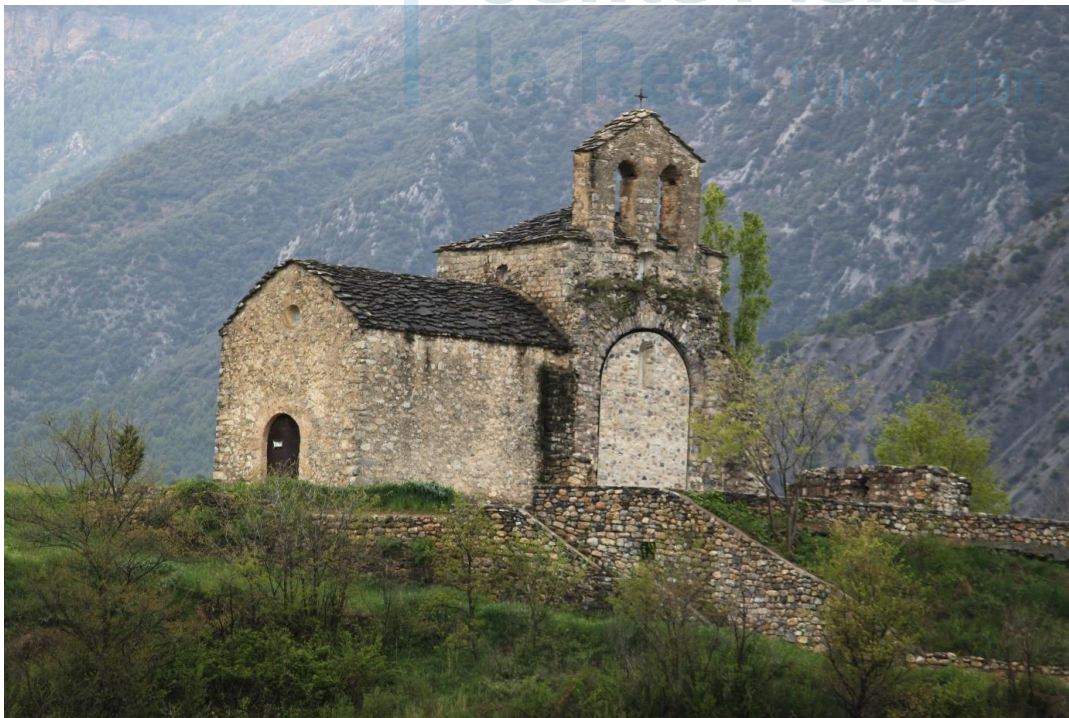
Vista general desde el sureste
