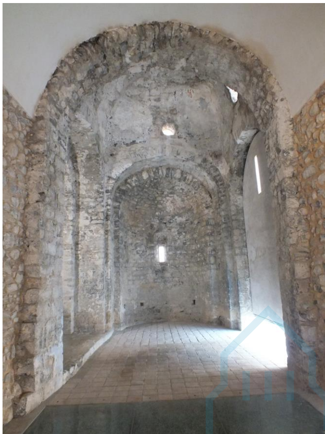
Interior del crucero y del ábside lateral norte
