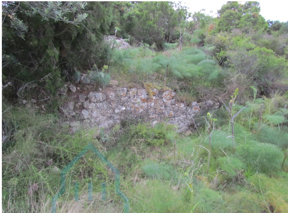
Restos del muro sur de la capilla del castillo
