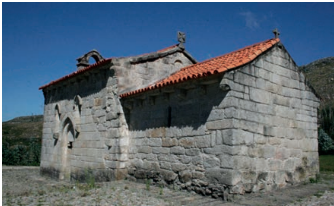
Perspetiva geral da igreja. Alçados sul e este
