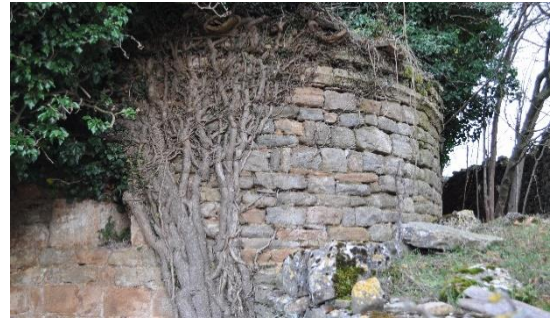
Muro del ábside
