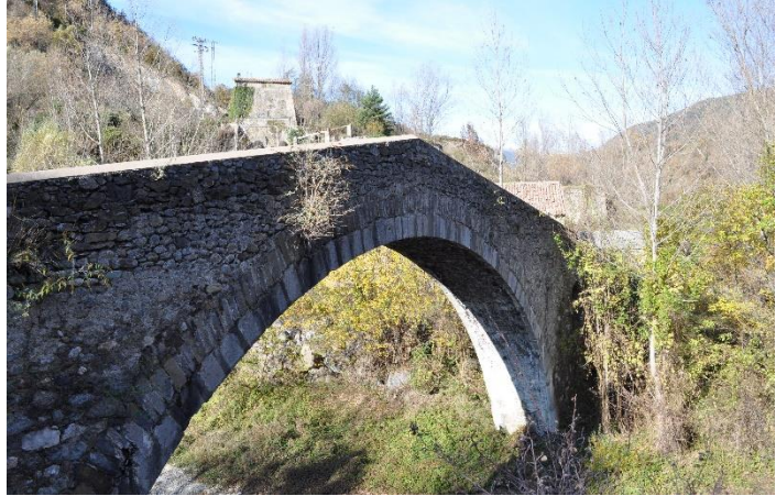
Vista del puente
