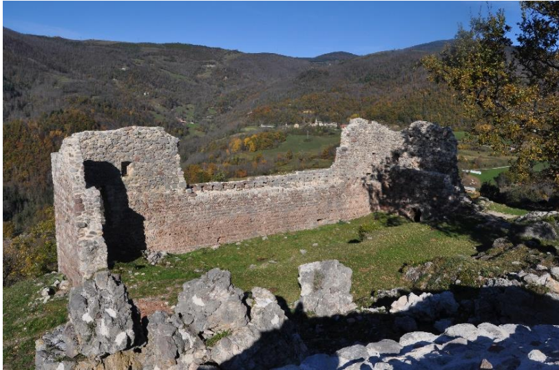
Estructuras del sector oeste
