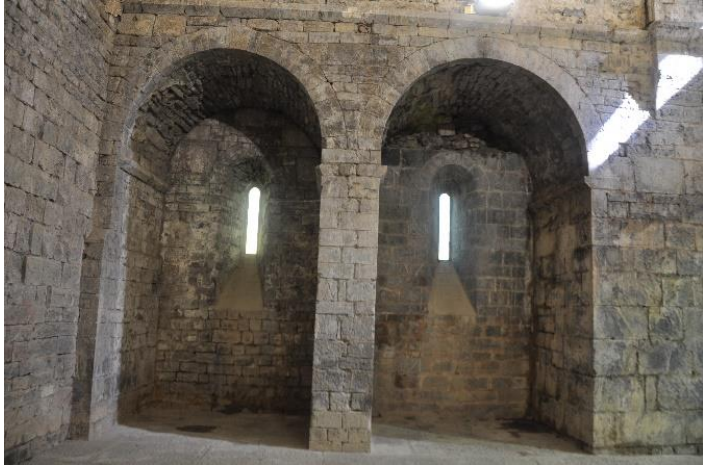
Capillas abiertas en el lado norte del transepto
