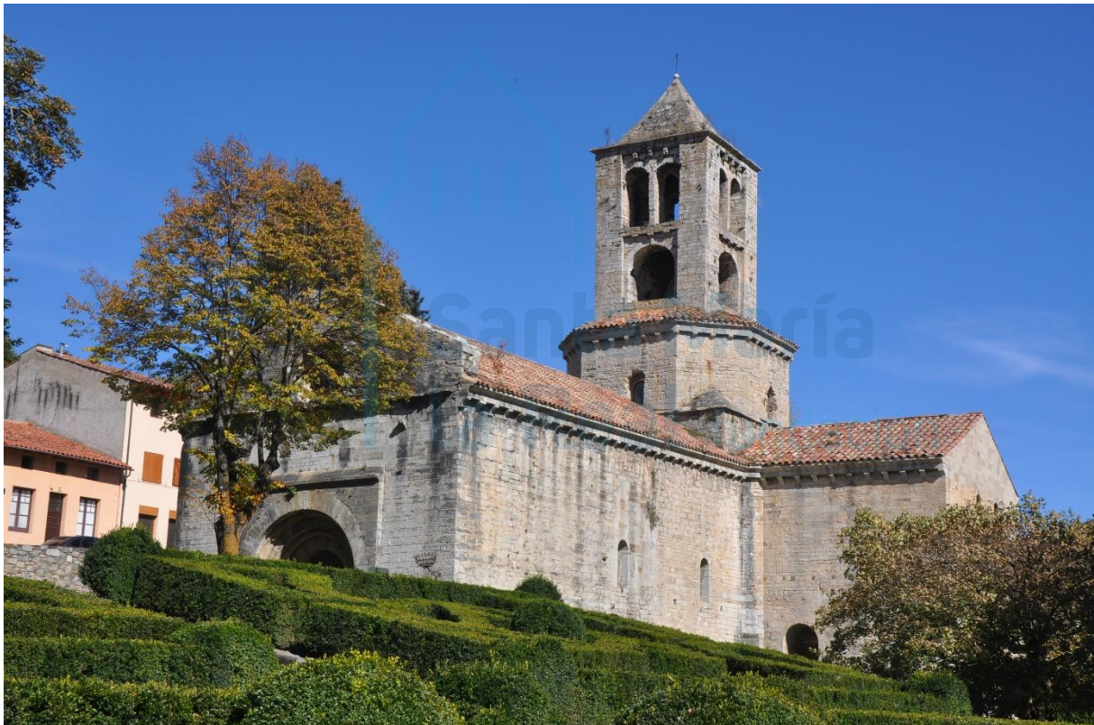
Vista general del conjunto
