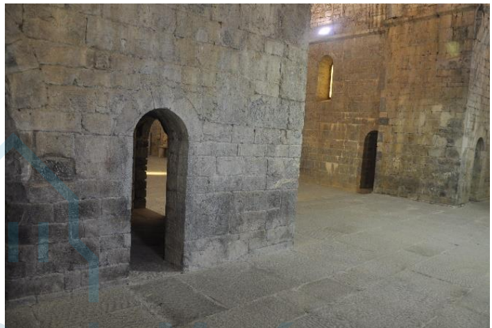
Corredor que da acceso al transepto
