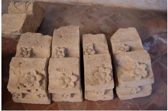
Dovelas de la tercera arquivolta de la portada (rectoría)
