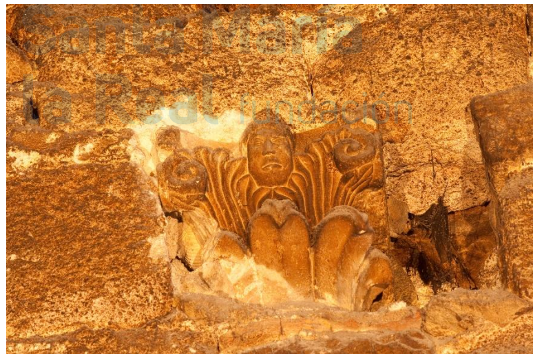
Capitel incrustado en el interior del campanario
