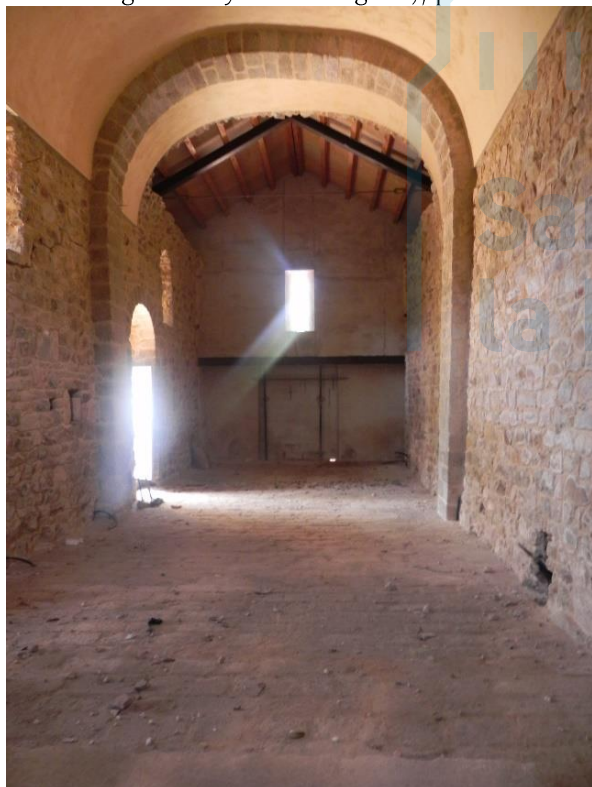
Interior (vista hacia el oeste)
