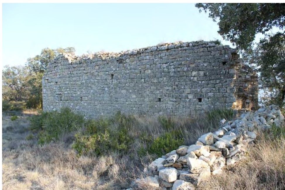
Vista exterior del muro norte
