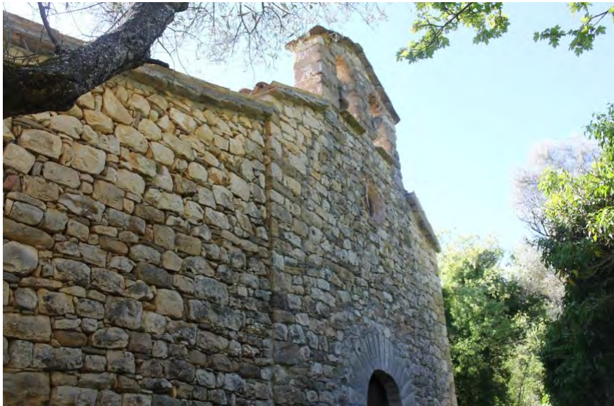
Vista exterior de la fachada oeste
