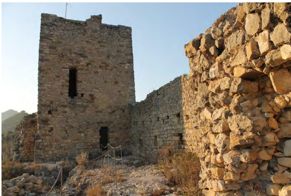
Vista del interior y de la cara este de la torre
