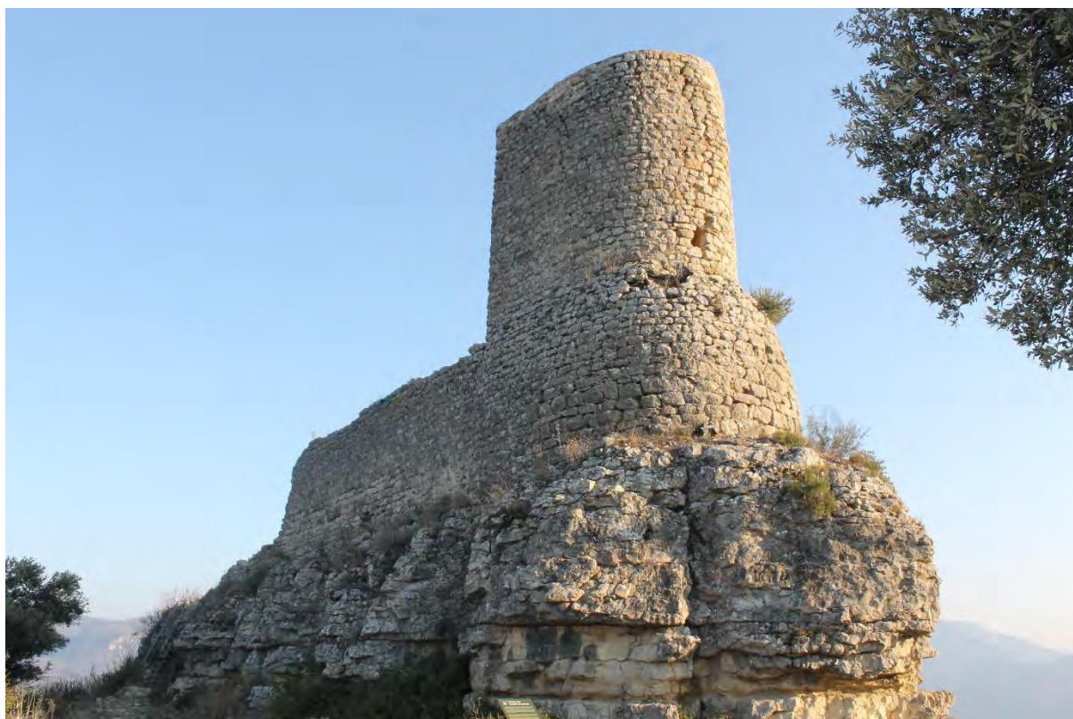
Vista general desde el noroeste
