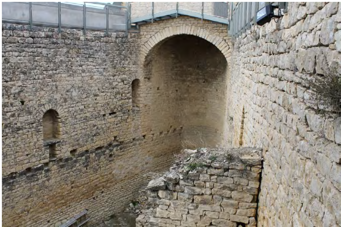
Vista interior, lado de poniente
