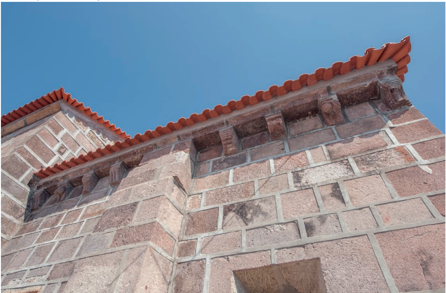
Abside. Contraforte e cachorrada no alçado sul
