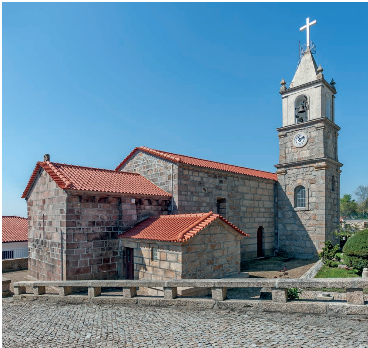
Perspetiva geral da igreja. Alçados leste e norte
