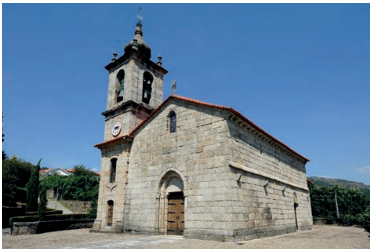
Perspetiva geral da igreja. Alçados sul e oeste
