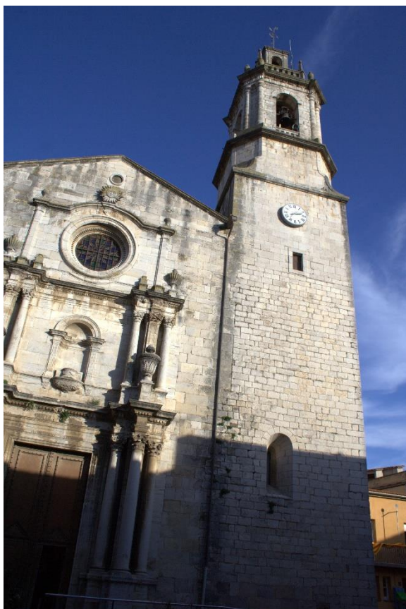
Vista de la fachada occidental
