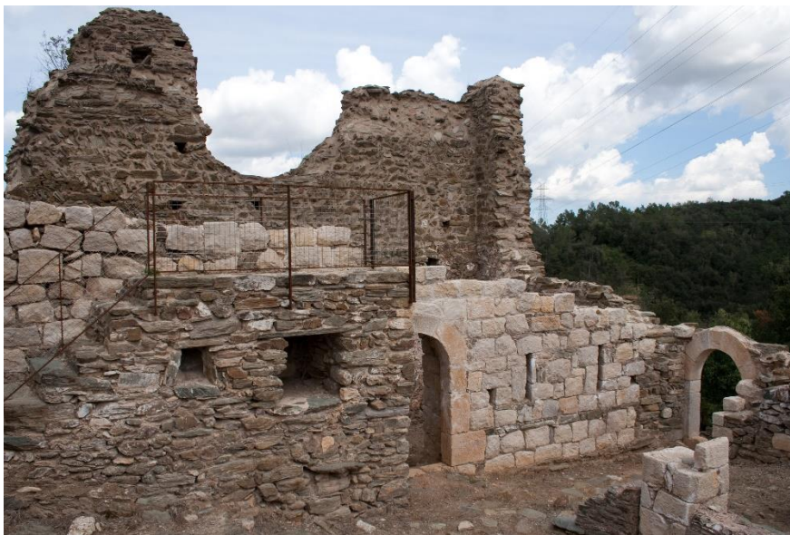
Vista del muro con sillares de talla
