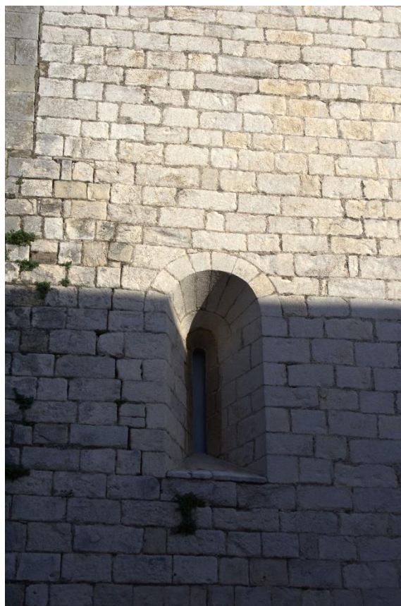
Detalle de paramento románico
