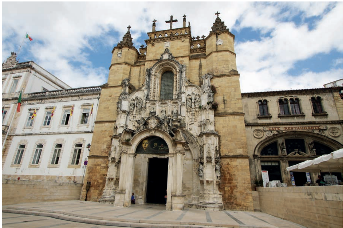
Perspetiva geral da igreja. Alçado oeste
