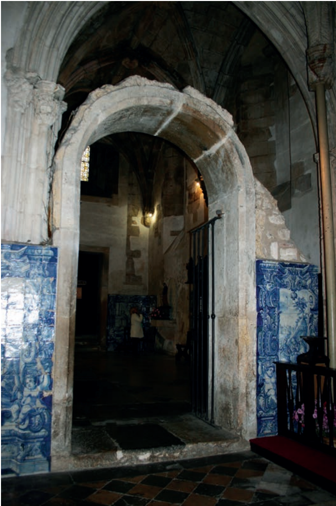
Interior da igreja. Arco de entrada da antiga capela dos Mártires de Marrocos
