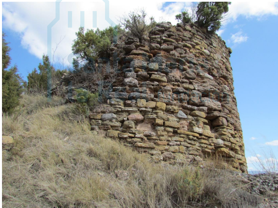
Detalle de la torre
