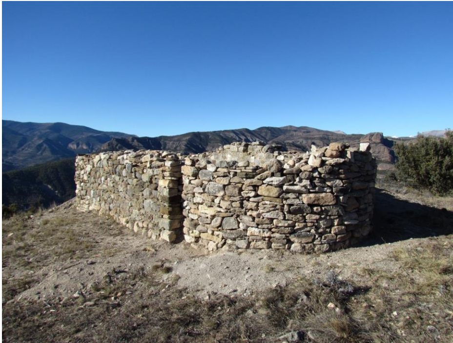
Vista general desde el sureste
