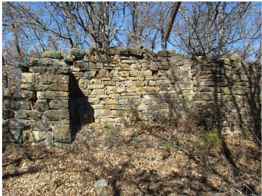
Vista exterior de los restos del muro sur
