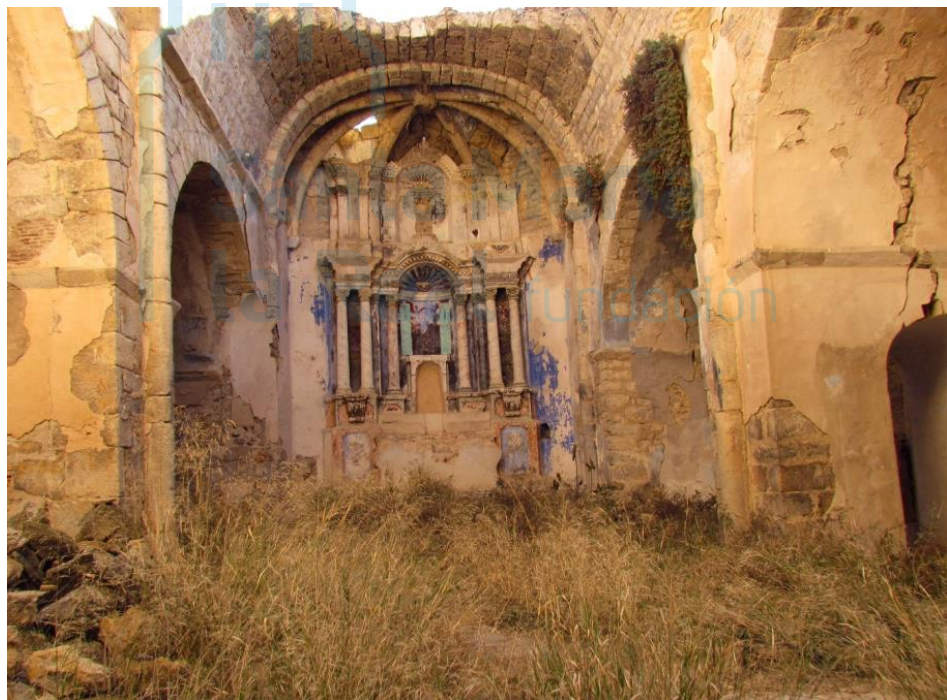
Vista del interior
