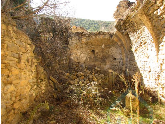
Vista del interior
