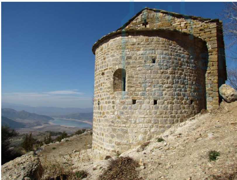
Vista del exterior del ábside
