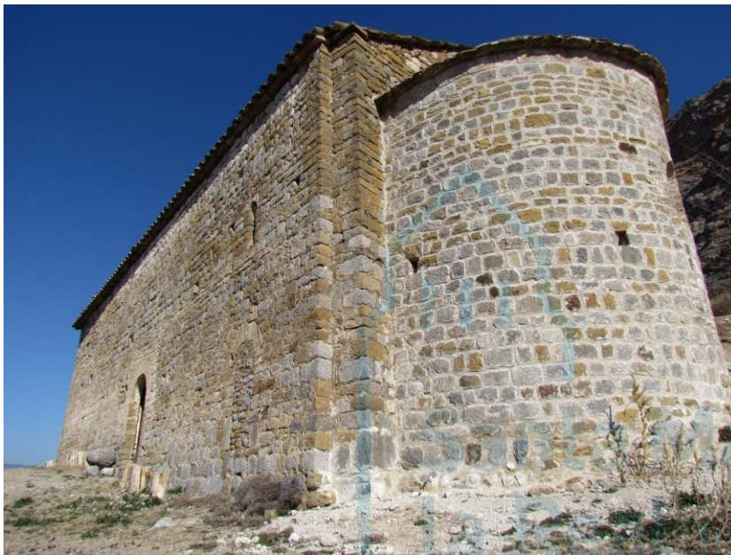
Vista exterior desde el sureste
