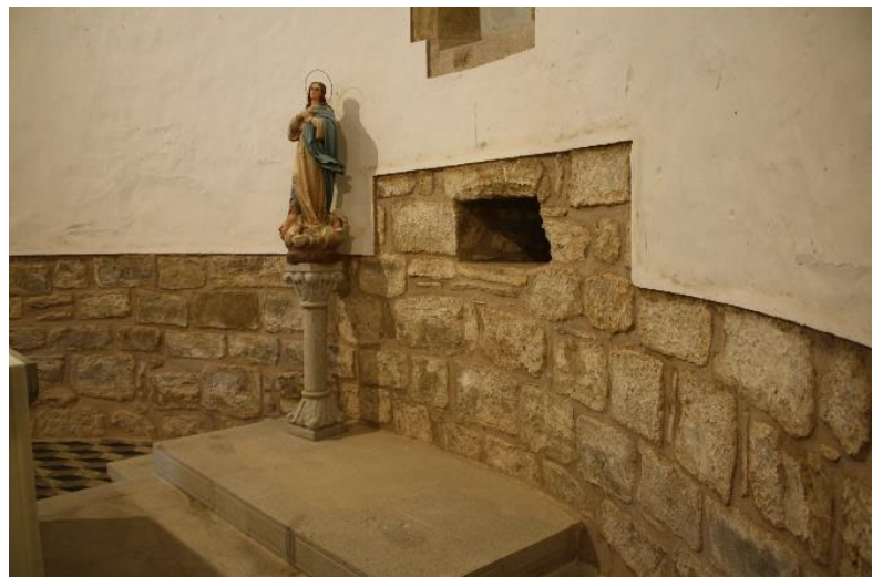
Detalle paramentos del ábside
