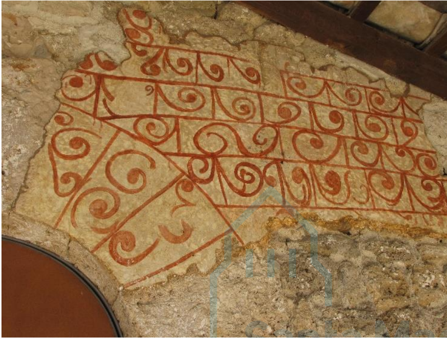
Detalle de pinturas en la fachada oeste
