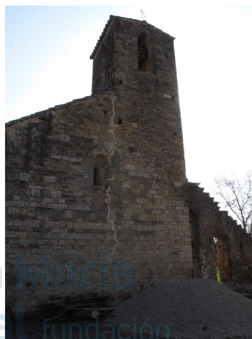
Fachada oeste y campanario
