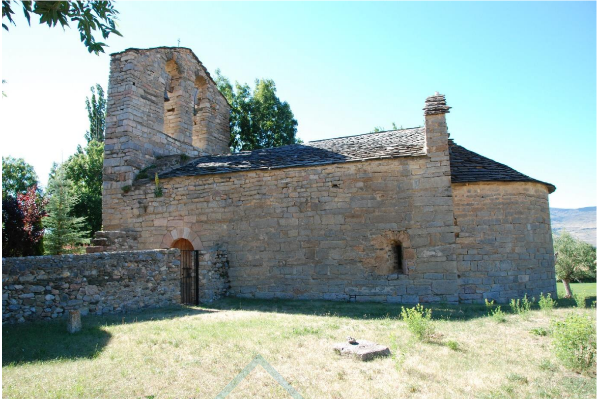
Vista general de la iglesia
