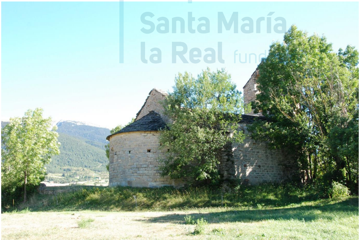
Vista general, lado norte
