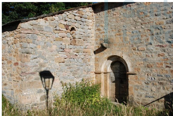
Vista meridional con puerta de acceso
